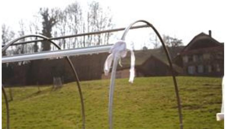
Als erstes werden nun die Folien (Pos. 9) der beiden Seitenteile aufgespannt und mit Kunststoff-Klemmprofilen befestigt. **Im Bogenbereich werden die PVC-Stücke (Pos. 12) benutzt, an den Beinen die langen Kunststoff-Profile (Pos. 10)**
