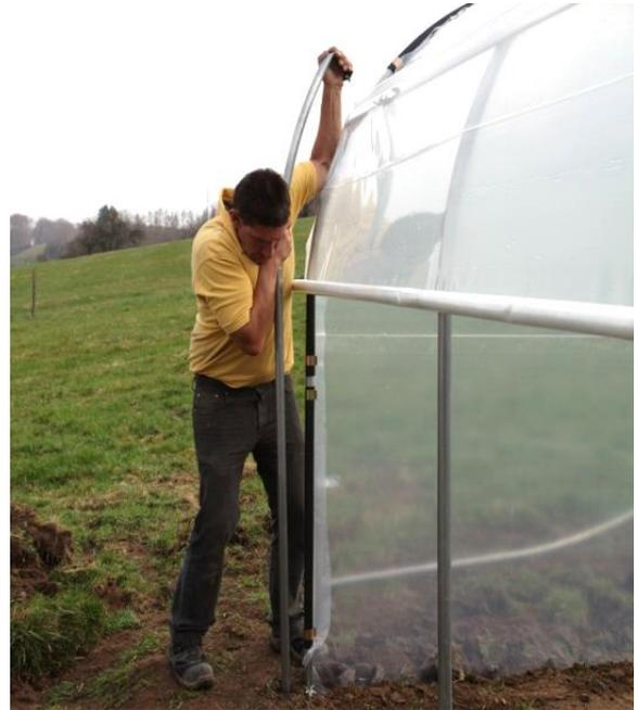
Das Führungsrohr wird dann mit einem Ringhalter an das Klemmprofil befestigt. Dazu wird eine Mutter seitlich in das Klemmprofil eingeführt bevor die Folie aufgezogen ist. Mit dem Messer können Sie einen Schlitz in die Folie schneiden wo der Gewindestift hindurch ragen soll.
