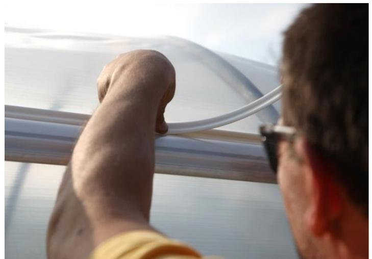
Das Rollrohr wird jetzt auf der Lüftungsseite, entlang des Tunnels auf den Boden gelegt.
