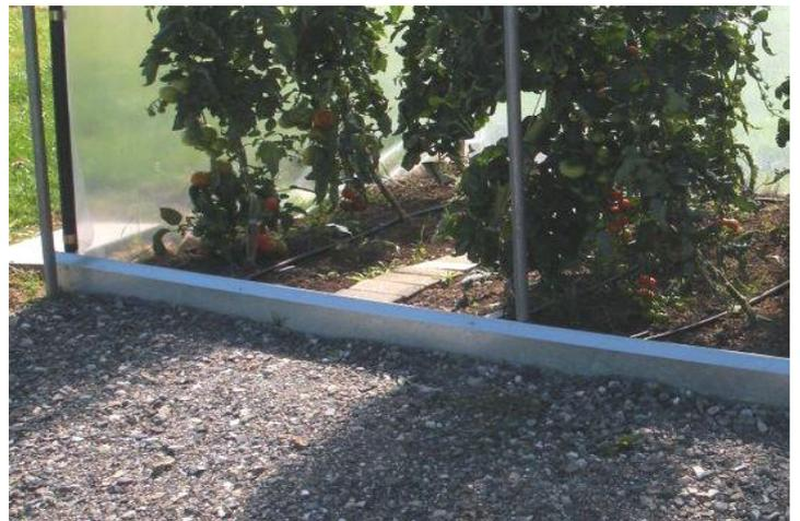
Anschließend werden die beiden Führungsrohre (Pos. 5) für die Frontlüftung, jeweils vor dem ersten und letzten Tunnelbogen, 5cm vor dem Bogen und 30cm tief, in den Boden gesteckt.
