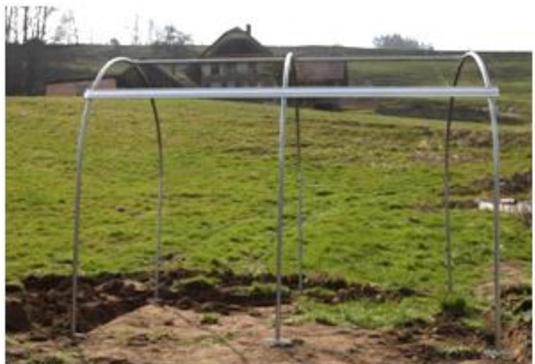
Danach müssen die Kanten des Klemmprofils mit einem Tuch oder Polster provisorisch abgedeckt werden, damit die Folie bei der Montage vor Verletzungen geschützt ist.
