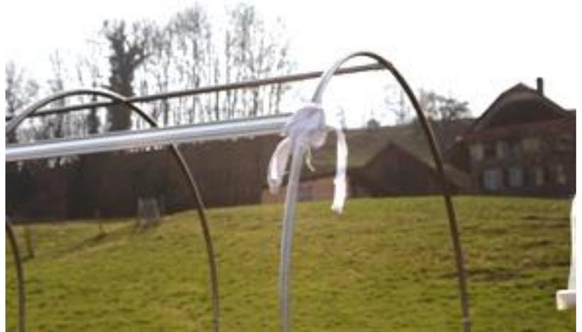
Als erstes werden nun die Folien (Pos. 9) der beiden Seitenteile aufgespannt und mit Klemmprofile schwarz, befestigt.
