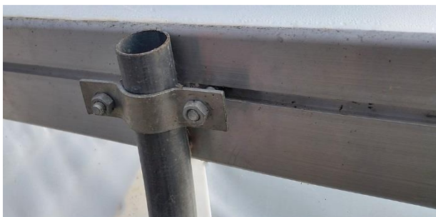
Befestigung mit Bandbride und 2 Sechskantschrauben M8x35mm (bereits vormontiert)
