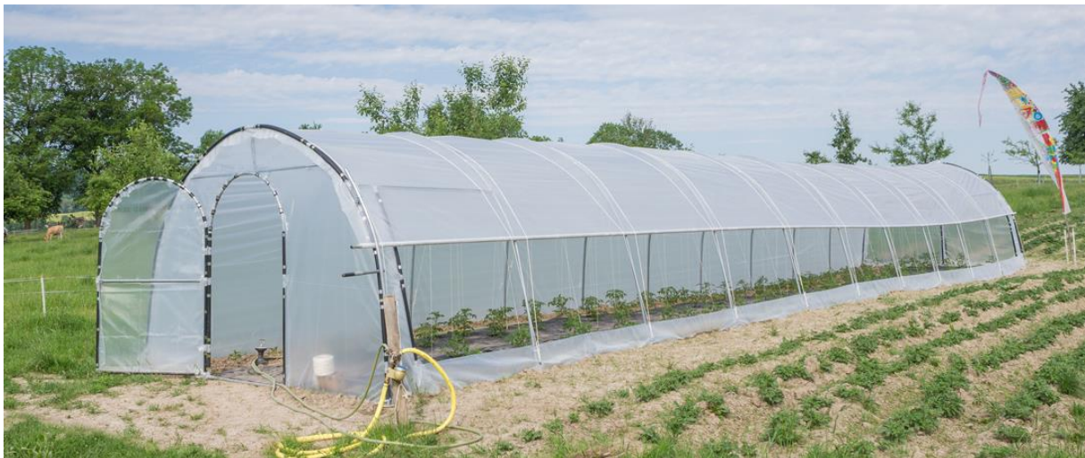
Seitenlüftung zum Aufrollen, mit Kurbel und Führung
